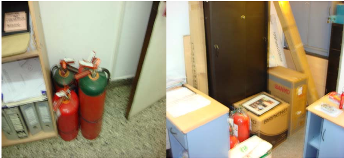
FOTO N°6 OFICINA MANTENIMIENTO BARRIAL
