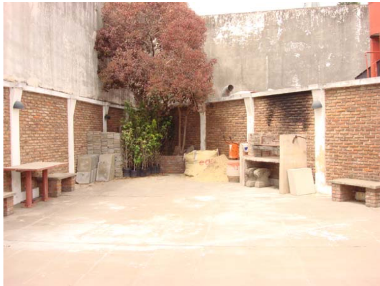
Foto N° 8 Acopio de material de construcción a cielo abierto
